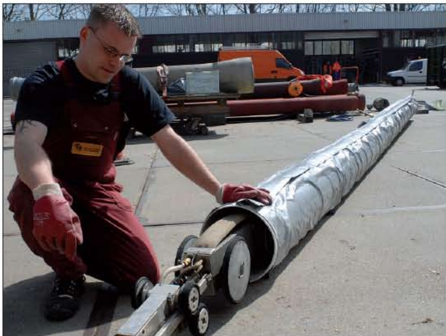
In de uitgeharde liner wordt een nieuwe robot gelaten.
