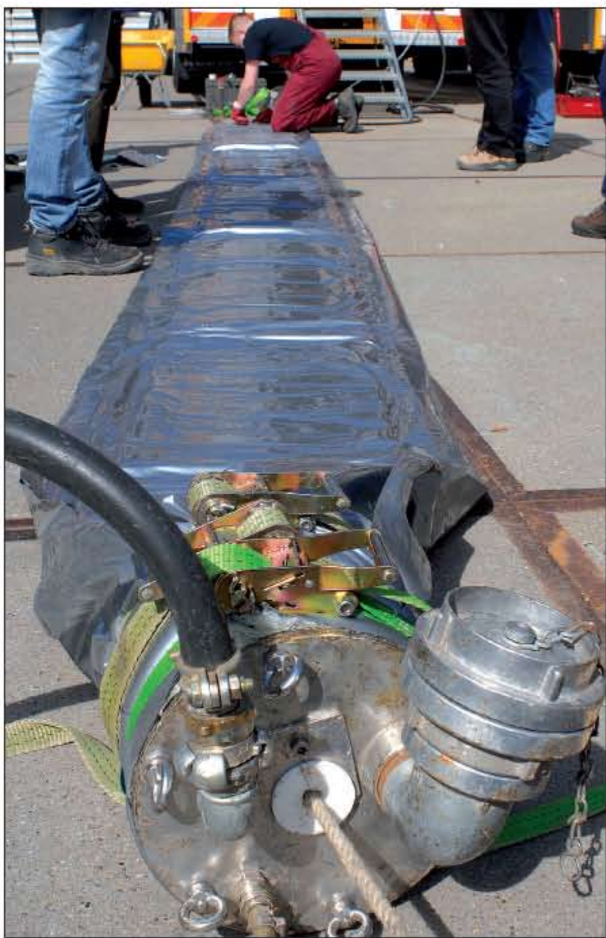
De nieuwe bekleding voor de rioolbuis wordt uitgerold en opgeblazen.
