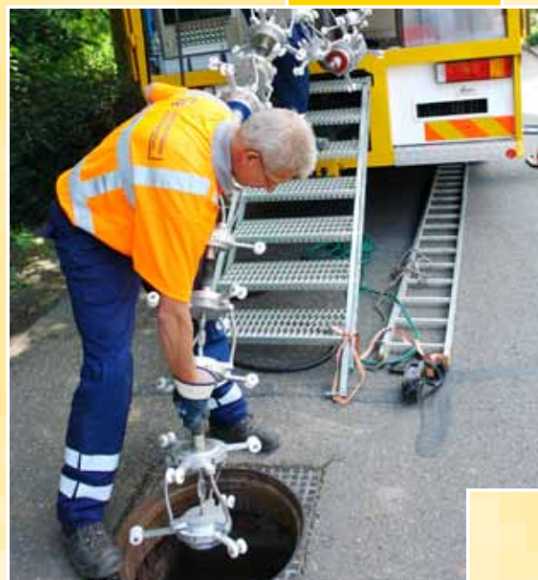
Invoeren van de lichttrein in het riool
